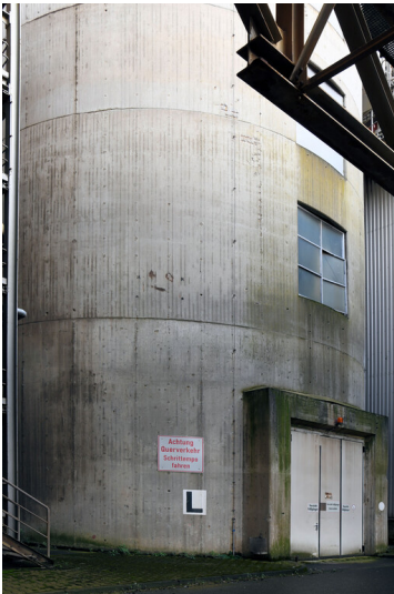
Kraftwerk Frimmersdorf II: Schornstein-Fundamentsockel Block L, Ansicht von Nordwesten; Foto: 21.03.2023 Fotograf/Urheber: Dr. Norbert Gilson
