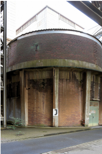
Kraftwerk Frimmersdorf II: Schornstein-Fundamentsockel Block J, Ansicht von Nordwesten; Foto: 21.03.2023 Fotograf/Urheber: Dr. Norbert Gilson
