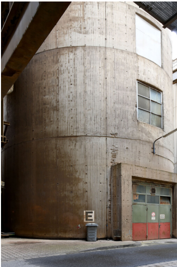
Kraftwerk Frimmersdorf II: Schornstein-Fundamentsockel Block E, Ansicht von Nordwesten; Foto: 21.03.2023 Fotograf/Urheber: Dr. Norbert Gilson
