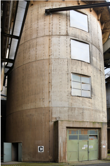
Kraftwerk Frimmersdorf II: Schornstein-Fundamentsockel Block C, Ansicht von Nordwesten; Foto: 21.03.2023 Fotograf/Urheber: Dr. Norbert Gilson
