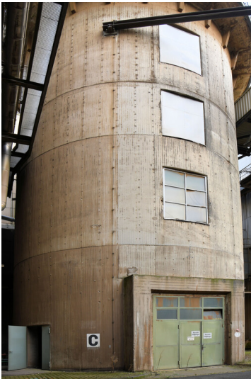
Kraftwerk Frimmersdorf II: Schornstein-Fundamentsockel Block C, Ansicht von Nordwesten; Foto: 21.03.2023 Fotograf/Urheber: Dr. Norbert Gilson
