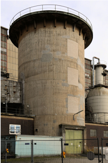
Kraftwerk Frimmersdorf II: Schornstein-Fundamentsockel Block B, Ansicht von Nordwesten; Foto: 21.03.2023 Fotograf/Urheber: Dr. Norbert Gilson
