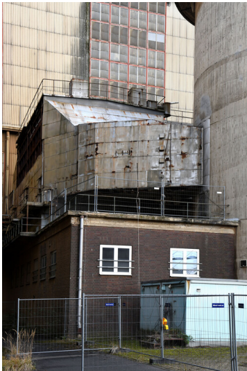
Kraftwerk Frimmersdorf II: Elektrofilter Block B, Rauchgaseinleitung in ehemaligen Schornstein B, Ansicht von Nordwesten; Foto: 21.03.2023 Fotograf/Urheber: Dr. Norbert Gilson
