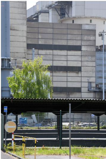
Kraftwerk Frimmersdorf II: Luvo-Schwerbau Block Q, Ansicht von Norden; Foto: 04.05.2023 Fotograf/Urheber: Dr. Norbert Gilson
