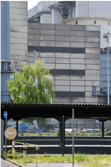
Kraftwerk Frimmersdorf II: Luvo-Schwerbau Block Q, Ansicht von Norden; Foto: 04.05.2023 Fotograf/Urheber: Dr. Norbert Gilson
