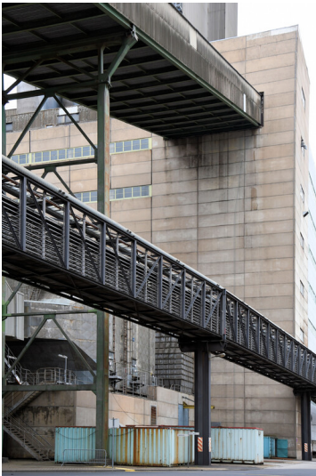
Kraftwerk Frimmersdorf II: Luvo-Schwerbau Block P, Einführung der von Brecherei 3 kommenden Bekohlungsbandbrücke, Ansicht von Westen; Foto: 22.03.2023 Fotograf/Urheber: Dr. Norbert Gilson
