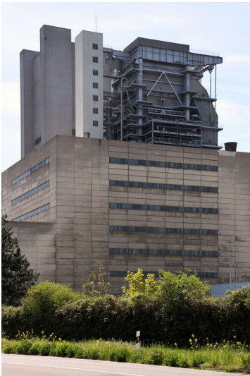
Kraftwerk Frimmersdorf II: Kesselhaus Block Q, Ansicht von Nordosten; Foto: 04.05.2023 Fotograf/Urheber: Dr. Norbert Gilson
