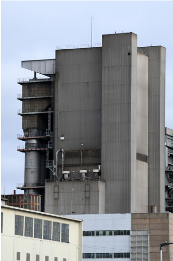
Kraftwerk Frimmersdorf II: Kesselhaus Block P, Ansicht von Süden; Foto: 22.03.2023 Fotograf/Urheber: Dr. Norbert Gilson
