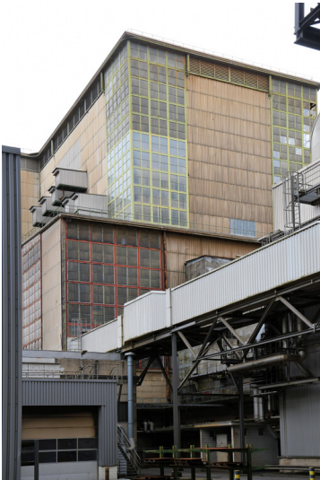
Kraftwerk Frimmersdorf II: Kesselhaus Block O, Ansicht von Nordwesten; Foto: 22.03.2023 Fotograf/Urheber: Dr. Norbert Gilson
