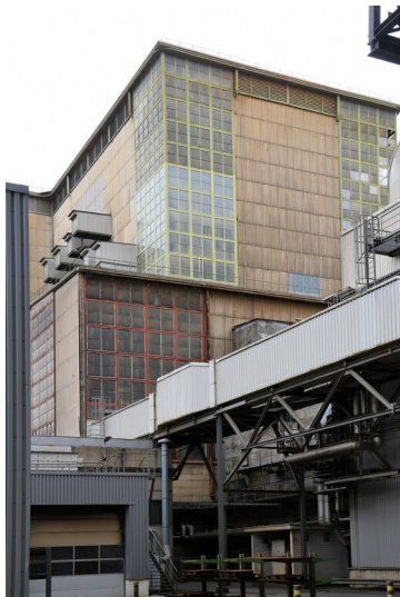
Kraftwerk Frimmersdorf II: Kesselhaus Block O, Ansicht von Nordwesten; Foto: 22.03.2023 Fotograf/Urheber: Dr. Norbert Gilson
