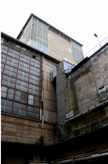
Kraftwerk Frimmersdorf II: Kesselhaus Block M, Ansicht von Nordwesten; Foto: 23.06.2023 Fotograf/Urheber: Dr. Norbert Gilson
