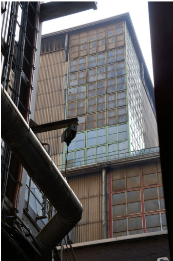
Kraftwerk Frimmersdorf II: Kesselhaus Block G, Ansicht von Westen; Foto: 23.06.2023 Fotograf/Urheber: Dr. Norbert Gilson
