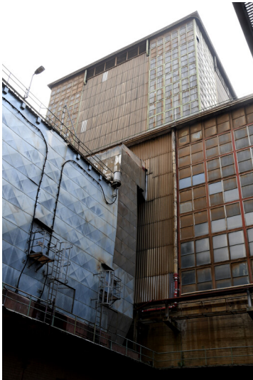
Kraftwerk Frimmersdorf II: Kesselhaus Block F, Ansicht von Westen; Foto: 23.06.2023 Fotograf/Urheber: Dr. Norbert Gilson
