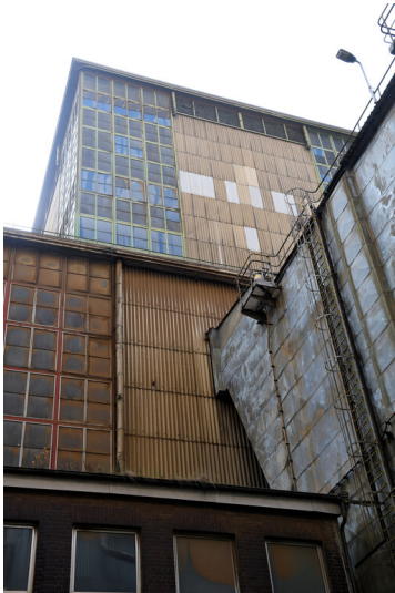
Kraftwerk Frimmersdorf II: Kesselhaus Block D, Ansicht von Nordwesten; Foto: 23.06.2023 Fotograf/Urheber: Dr. Norbert Gilson
