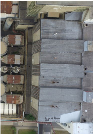
Kraftwerk Frimmersdorf II: Kesselhaus (jeweils zwei Kessel pro Block) Block A (im Bild unten) und Block B (oben), Ansicht Drohnenüberflug-Foto; Foto: Juli 2017 Fotograf/Urheber: RWE Power AG
