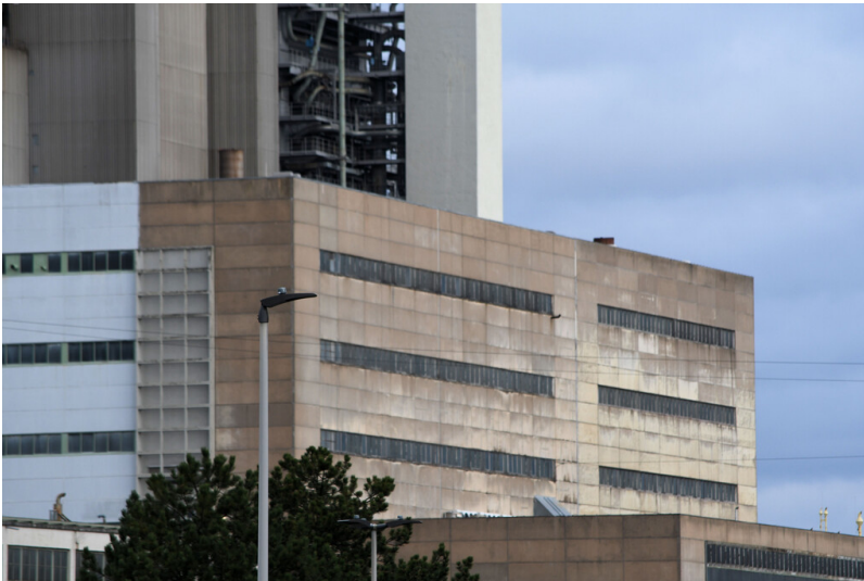
Kraftwerk Frimmersdorf II: Speisepumpen-Schwerbau Blöcke P/Q, Ansicht von Süden; Foto: 22.03.2023 Fotograf/Urheber: Dr. Norbert Gilson
