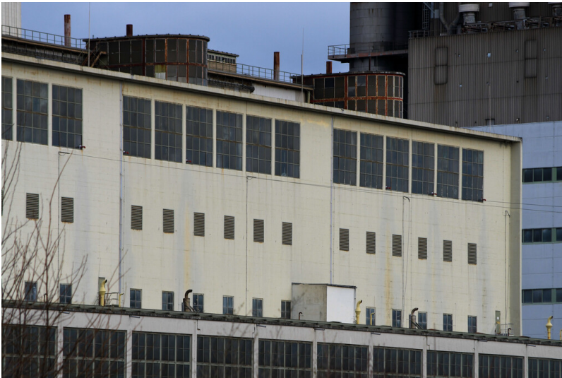
Kraftwerk Frimmersdorf II: Schwerbau Blöcke N/O, Ansicht von Südosten; Foto: 22.03.2023 Fotograf/Urheber: Dr. Norbert Gilson
