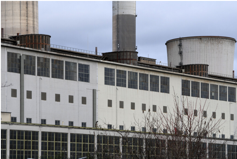
Kraftwerk Frimmersdorf II: Schwerbau Blöcke K/L/M, Ansicht von Südosten; Foto: 22.03.2023 Fotograf/Urheber: Dr. Norbert Gilson
