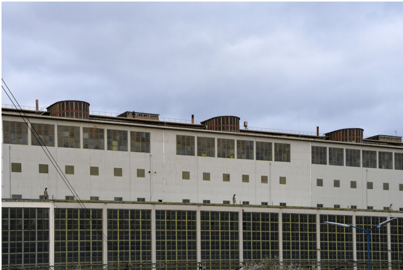
Kraftwerk Frimmersdorf II: Schwerbau Blöcke G/H/J, Ansicht von Südosten; Foto: 22.03.2023 Fotograf/Urheber: Dr. Norbert Gilson
