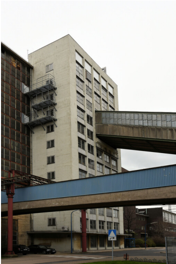
Kraftwerk Frimmersdorf II: Schwerbau Blöcke A/B, Kopfbau von Block A, Ansicht von Westen; Foto: 22.03.2023 Fotograf/Urheber: Dr. Norbert Gilson
