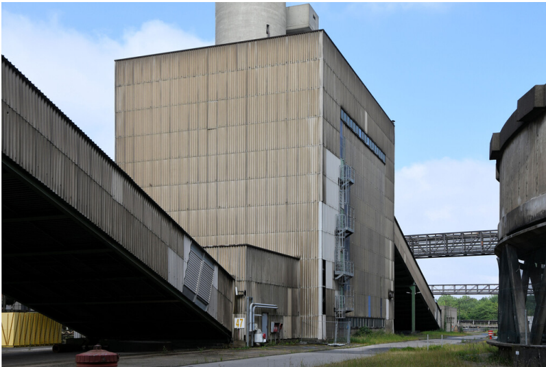
Kraftwerk Frimmersdorf II: Brecherei 3, Ansicht von Osten; Foto: 23.06.2023 Fotograf/Urheber: Dr. Norbert Gilson
