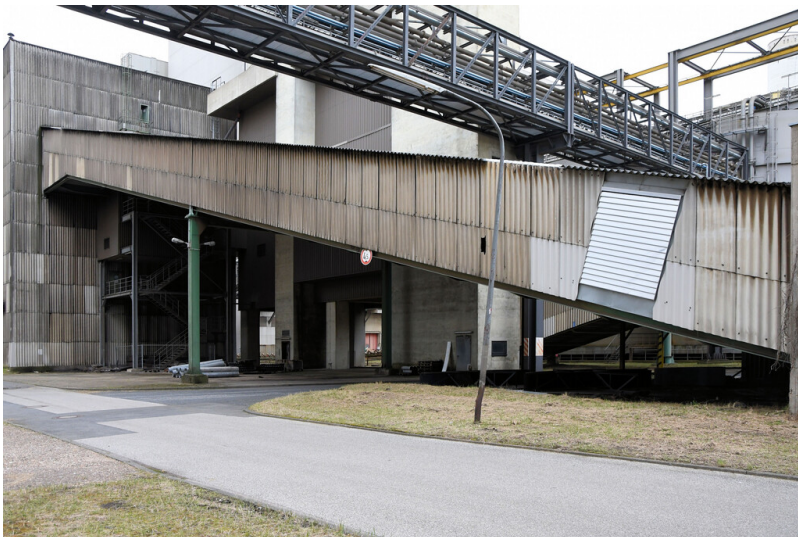
Kraftwerk Frimmersdorf II: Bandbrücke von der Eisenausscheidung 3 zur Brecherei 3, Ansicht von Nordwesten; Foto: 22.03.2023 Fotograf/Urheber: Dr. Norbert Gilson
