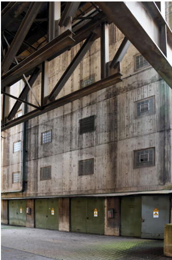
Kraftwerk Frimmersdorf II: Bekohlungssecturm 2, Schaltanlage, Ansicht von Osten; Foto: 21.03.2023 Fotograf/Urheber: Dr. Norbert Gilson
