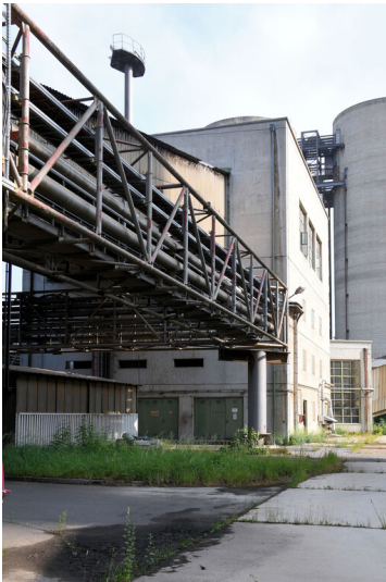
Kraftwerk Frimmersdorf II: Brecherei 2, Ansicht von Süden; Foto: 23.06.2023 Fotograf/Urheber: Dr. Norbert Gilson
