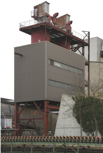
Kraftwerk Frimmersdorf II: TAV-Anlage 2 für den Bekohlungsweg zu den Blöcken K/L, Ansicht von Westen; Foto: 22.03.2023 Fotograf/Urheber: Dr. Norbert Gilson
