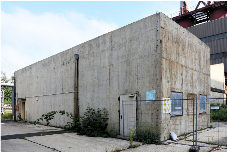
Kraftwerk Frimmersdorf II: Eisenausscheidung 2, Ansicht von Süden; Foto: 23.06.2023 Fotograf/Urheber: Dr. Norbert Gilson
