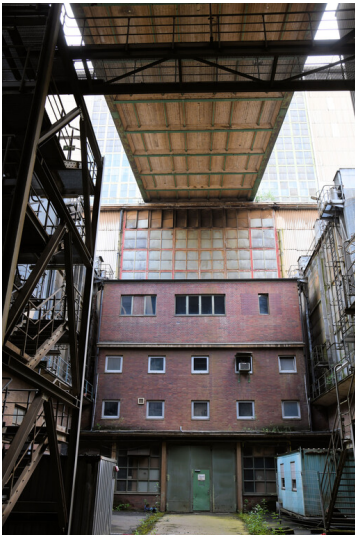
Kraftwerk Frimmersdorf II: Bekohlungsbandbrücke, Einführung in den Schwerbau zwischen den Blöcken K und L, Ansicht von Westen; Foto: 23.06.2023 Fotograf/Urheber: Dr. Norbert Gilson
