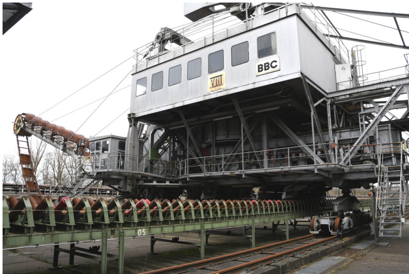
Kraftwerk Frimmersdorf II: Bunkerbagger VIII im Grabenbunker 2, Ansicht von Südosten; Foto: 22.03.2023 Fotograf/Urheber: Dr. Norbert Gilson
