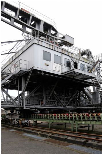
Kraftwerk Frimmersdorf II: Bunkerbagger VII im Grabenbunker 2, Bandaufgabevorrichtung, Ansicht von Nordosten; Foto: 22.03.2023 Fotograf/Urheber: Dr. Norbert Gilson
