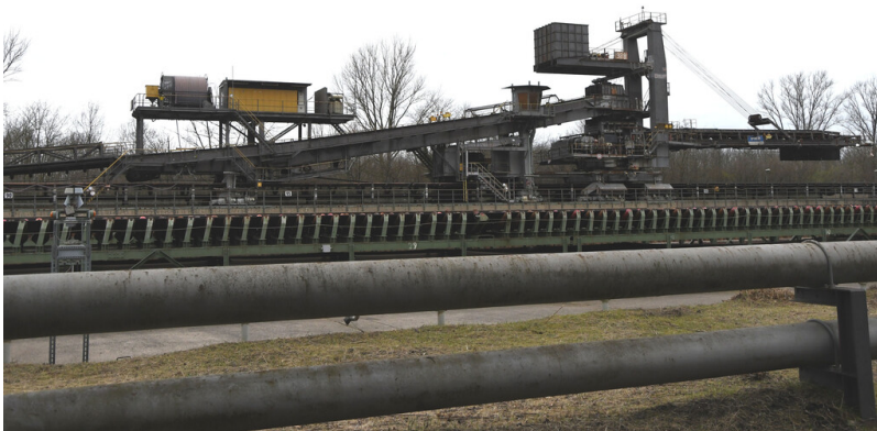
Kraftwerk Frimmersdorf II: Bandschleifenwagen 988 am Grabenkunker 2, Ansicht von Osten; Foto: 22.03.2023 Fotograf/Urheber: Dr. Norbert Gilson
