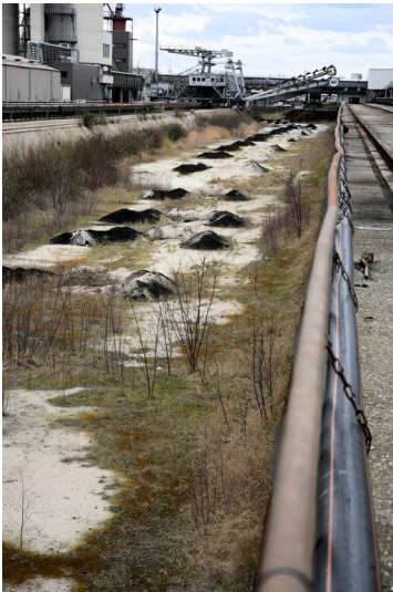
Kraftwerk Frimmersdorf II: Grabenbunker 2, Ansicht von Norden; Foto: 22.03.2023 Fotograf/Urheber: Dr. Norbert Gilson
