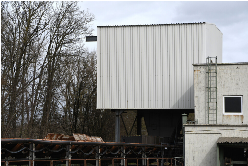
Kraftwerk Frimmersdorf II: Kohlebeschickung von Grabenbunker 2, Kohleleckturm West 2, Ansicht von Süden; Foto: 22.03.2023 Fotograf/Urheber: Dr. Norbert Gilson
