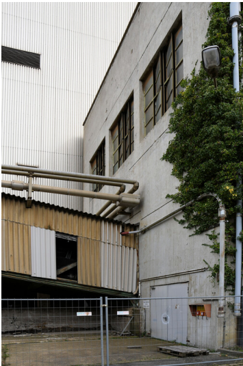
Kraftwerk Frimmersdorf II: Bekohlungsleckturm 1 mit Ausgang der Bandbrücke zum Verteilgebäude, Ansicht von Südwesten; Foto: 22.03.2023 Fotograf/Urheber: Dr. Norbert Gilson
