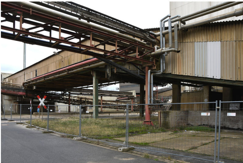
Kraftwerk Frimmersdorf II: Kohlebandbrücke von Kohleleckturm 1 zum Verteilgebäude, Ansicht von Südosten; Foto: 22.03.2023 Fotograf/Urheber: Dr. Norbert Gilson
