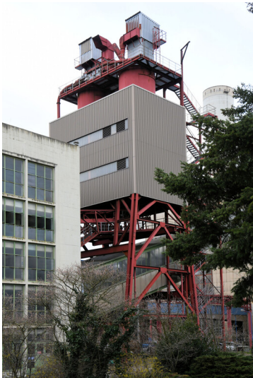
Kraftwerk Frimmersdorf II: TAV-Anlage im Bekohlungsweg Grabenbunker 1 - Schwerbau Block A, Ansicht von Südosten; Foto: 22.03.2023 Fotograf/Urheber: Dr. Norbert Gilson
