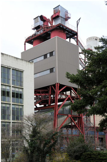
Kraftwerk Frimmersdorf II: TAV-Anlage im Bekohlungsweg Grabenbunker 1 - Schwerbau Block A, Ansicht von Südosten; Foto: 22.03.2023 Fotograf/Urheber: Dr. Norbert Gilson
