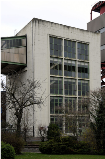
Kraftwerk Frimmersdorf II: Brecherei 1, Ansicht von Südosten; Foto: 22.03.2023 Fotograf/Urheber: Dr. Norbert Gilson
