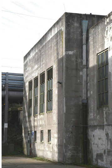
Kraftwerk Frimmersdorf II: Eisenausscheidung 1, Ansicht von Nordosten; Foto: 22.03.2023 Fotograf/Urheber: Dr. Norbert Gilson
