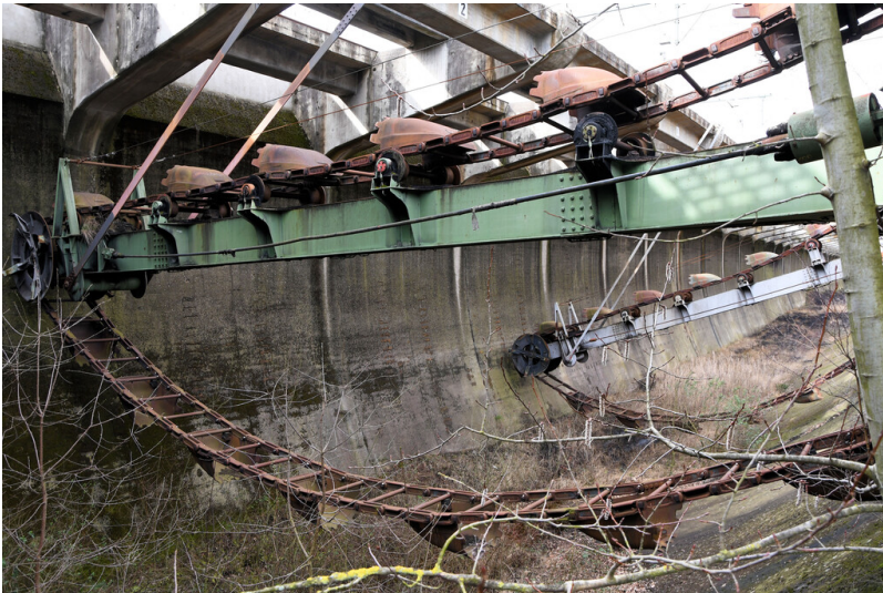
Kraftwerk Frimmersdorf II: Bunkerbagger 1, Eimerkette, Ansicht von Osten; Foto: 22.03.2023 Fotograf/Urheber: Dr. Norbert Gilson
