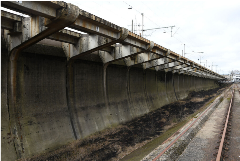
Kraftwerk Frimmersdorf II: Grabenbunker 1, Ansicht von Nordosten; Foto: 22.03.2023 Fotograf/Urheber: Dr. Norbert Gilson
