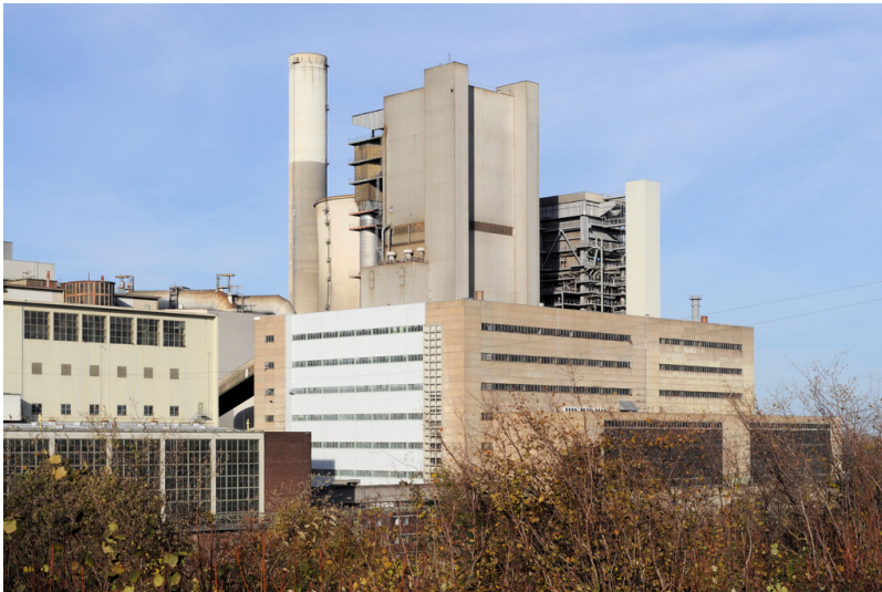
Kraftwerk Frimmersdorf II: Kesselhäuser Blöcke P und Q, Ansicht von Südosten; Foto: 13.11.2020 Fotograf/Urheber: Dr. Norbert Gilson
