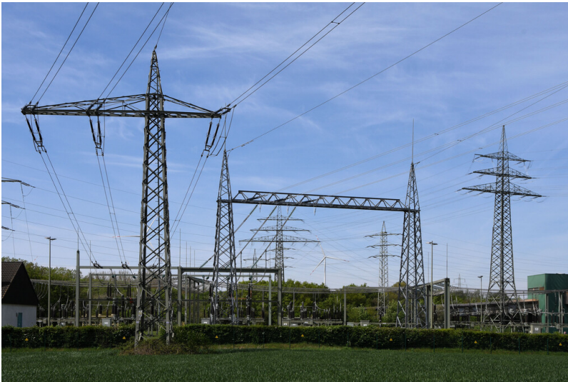
Kraftwerk Frimmersdorf I: 110-kV-Schaltanlage Frimmersdorf, Abspannmasten und Abspanngerüst, Ansicht von Osten; Foto: 04.05.2023 Fotograf/Urheber: Dr. Norbert Gilson
