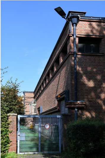
Kraftwerk Frimmersdorf I: 6-kV-Schaltheis, Ansicht von Südwesten; Foto: 14.09.2023 Fotograf/Urheber: Dr. Norbert Gilson
