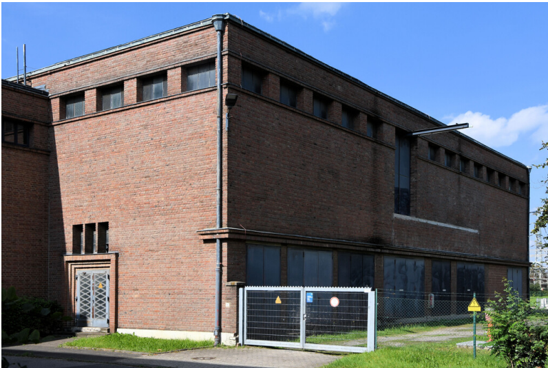
Kraftwerk Frimmersdorf I: 55-kV-Schaltheis, Ansicht von Süden; Foto: 14.09.2023 Fotograf/Urheber: Dr. Norbert Gilson
