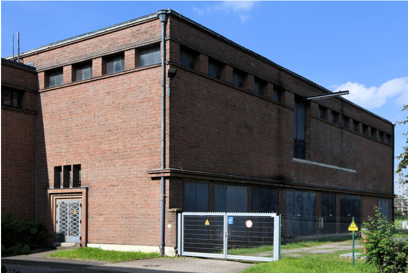
Kraftwerk Frimmersdorf I: 55-kV-Schaltheis, Ansicht von Süden; Foto: 14.09.2023 Fotograf/Urheber: Dr. Norbert Gilson
