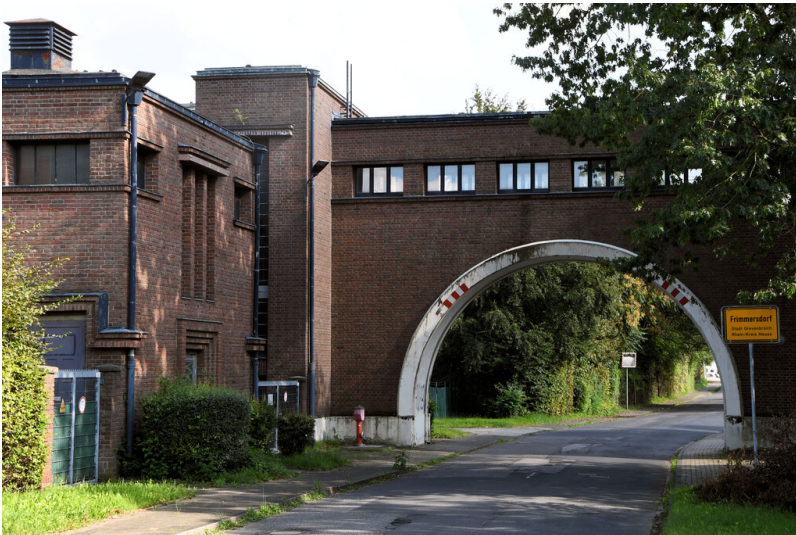
Kraftwerk Frimmersdorf I: Torbogenbauwerk, Ansicht von Nordwesten; Foto: 14.09.2023 Fotograf/Urheber: Dr. Norbert Gilson
