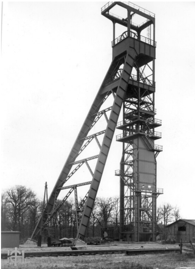
Schachtanlage Union 103: Fördergerüst von Schacht II; Foto: 1953 Fotograf/Urheber: Historisches Konzernarchiv RWE
