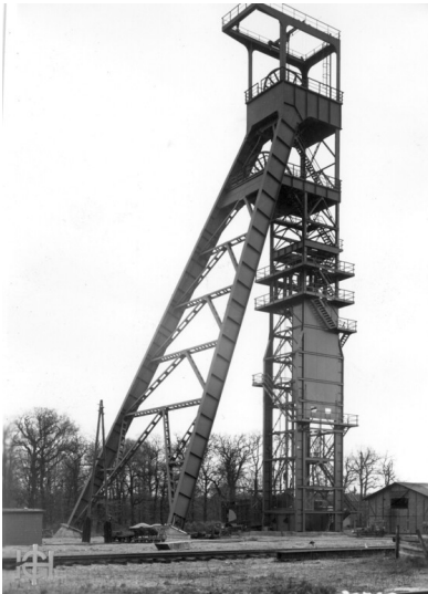
Schachtanlage Union 103: Fördergerüst von Schacht II; Foto: 1953 Fotograf/Urheber: Historisches Konzernarchiv RWE
