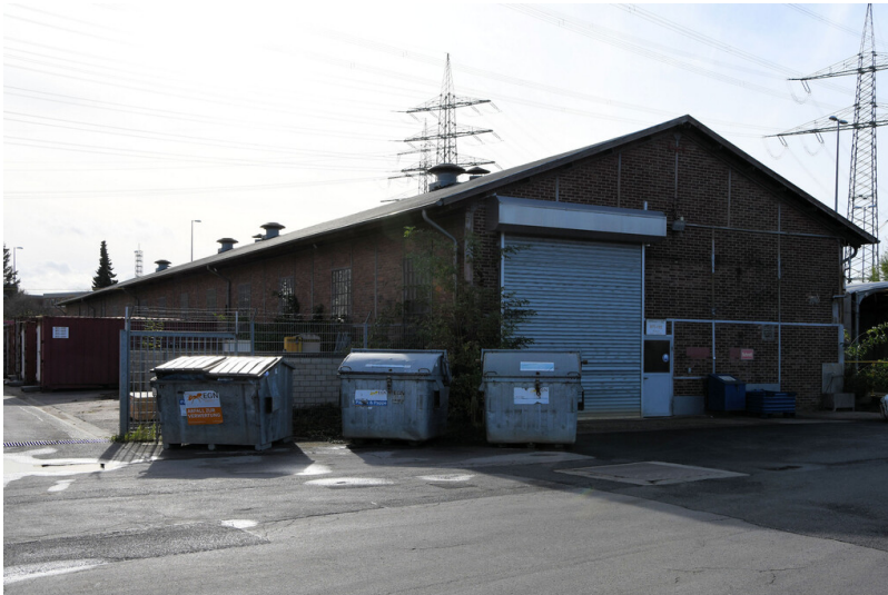
Tagebau Inden: Vorrichtungshalle, Ansicht von Nordosten; Foto: 09.11.2022 Fotograf/Urheber: Dr. Norbert Gilson
