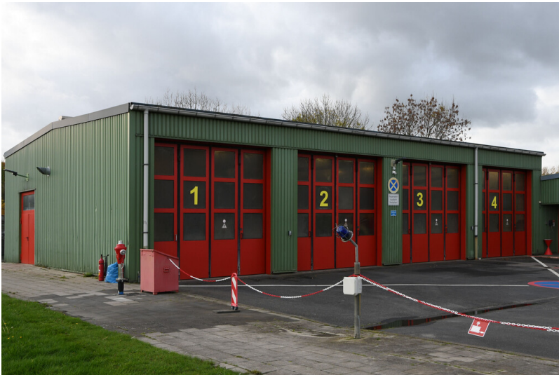
Tagebau Inden: Garage für Feuerwehrfahrzeuge, Ansicht von Osten; Foto: 09.11.2022 Fotograf/Urheber: Dr. Norbert Gilson
