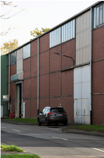
Tagebau Inden: Kranhalle, Ansicht von Westen; Foto: 09.11.2022 Fotograf/Urheber: Dr. Norbert Gilson
